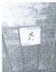
Identificación de rótulo deteriorado (Yaxha)
